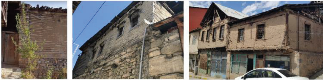
Görsel 64-65-66. Uzundere Kirazlı ve Dikyar Köyü (Mehmet Ali Arslan) ile İspir ilçe merkezinde (Mehmet Ali Adem) bağdadi örgü
