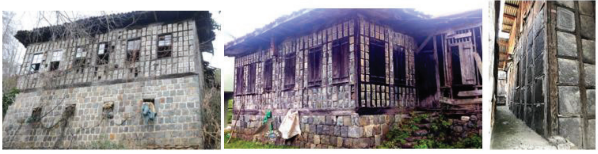
Görsel 67-68-69. Artvin/Arhavi Şenköy Kenan Erol Evi (Kültür Portalı, 2023) Rize (Engin Algül, 2023) ve Uzundere/Dikyar (Tahsin Okur) (Önal, 2020: 510) köyünde göz dolma tekniği ile yapılan duvar örgüsü
