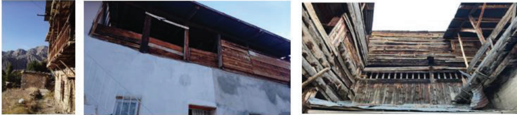
Görsel 61-62-63. Uzundere Kirazlı, Çağlayanlı (Mehmet Örnek) ve Dikyar (Tahsin Okur) köylerinde ahşabın yoğun kullanıldığı üst katlar
