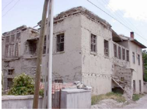
Şekil 23. Tartan Konağı'nın restorasyondan önceki durumu
