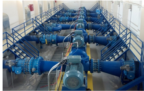
Şekil 8. Mevcut demontaj sistemlerinin hat içerisinde yerleşimi
