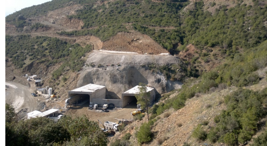
Şekil 3. Tüneli giriş portal kesim (Mersin – Anamur Yönü)
