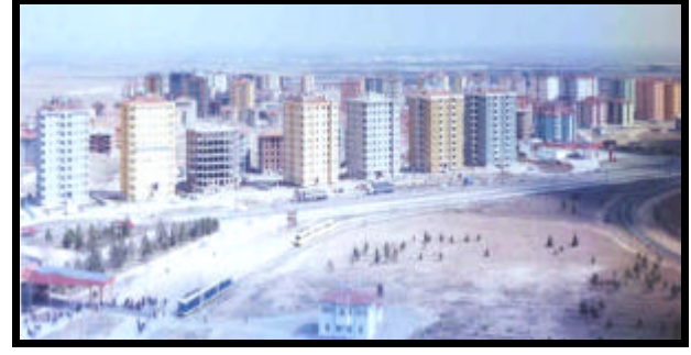
Sekil 1. Bosna-Hersek mahallesinde yeşil alandan yoksun artan yoğun dikey yapılaşma (Orijinal 2003).
