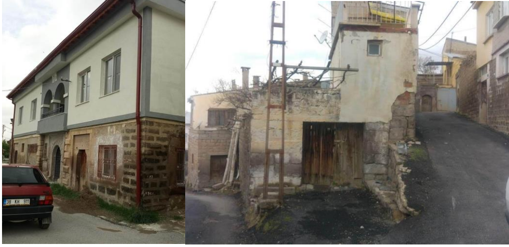
Resim 3. Restorasyonu aslına uygun yapılmayan yapılar (Topal, 2022)
