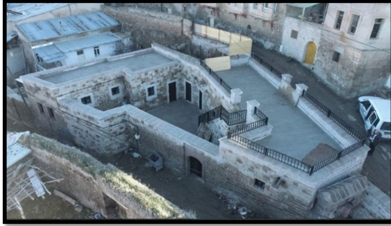
Resim 2. Restorasyonu Melikgazi Belediyesi tarafından yapılan abdesthane ve çeşme (Topal, 2022)
