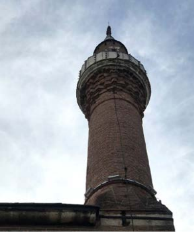
Görsel 8 Üftâde Camii'nin tuğla minaresi
