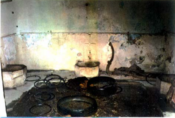
Sıcaklık bölümünde kurna taşları ve bugünkü hâli
