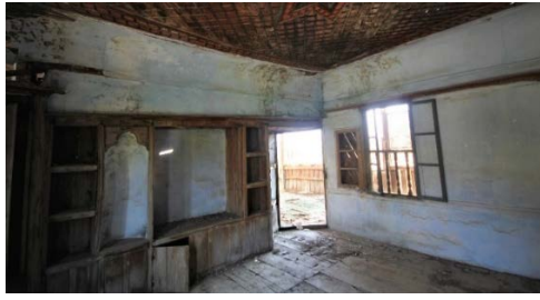
Foto 7. Güneybatı oda dolapları
