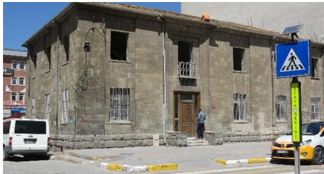
Şekil 4. Van Tekel Binası-2021(Fotoğraf yazara aittir.)
