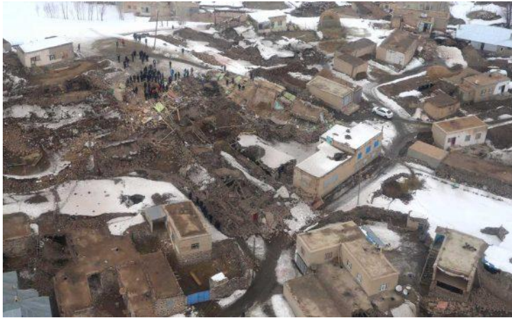
Şekil 73. Deprem Görmüş Bir Köyde Yığma Yapı Hasarı (Van-Başkale 2021)
