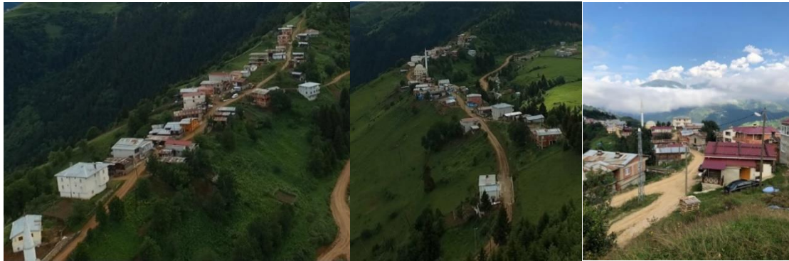
Şekil 12: Yerel Peyzajla Uyumsuz Betonarme Yapılaşma (Topcu, 2021)
