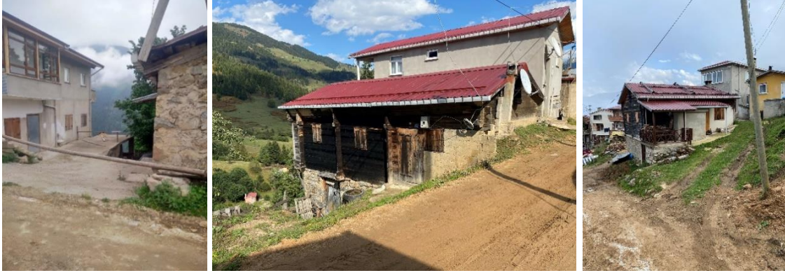
Şekil 13: Yerel Konutların Yakın Çevresine Yapılan Betonarme Yapılar (Topcu, 2021)
