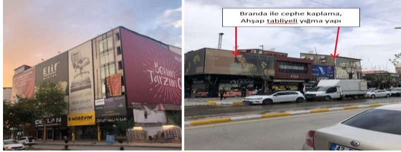
Şekil 41,42. Van Cumhuriyet Caddesi Cephe Giydirmesi Yapılmış Yığma Yapı Örnekleri (Fotoğraflar Yazara Aittir)
