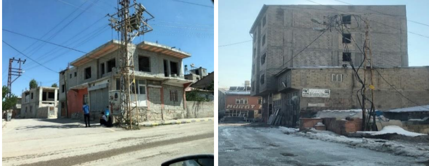
Şekil 35,36. Kent Dokusunu Bozan Eksik Yapı Örnekleri, Bostaniçi Mahallesi
