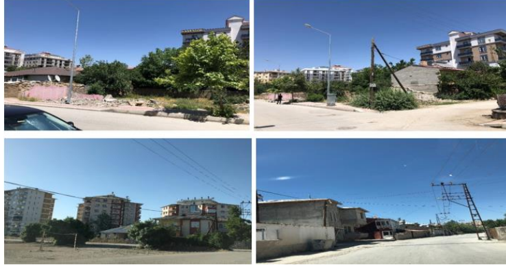
Şekil 22-25. Planlama Disiplini Olmayan Kötü Tasarım Yapı Örnekleri, Van Şerefiye Mahallesi-2021
