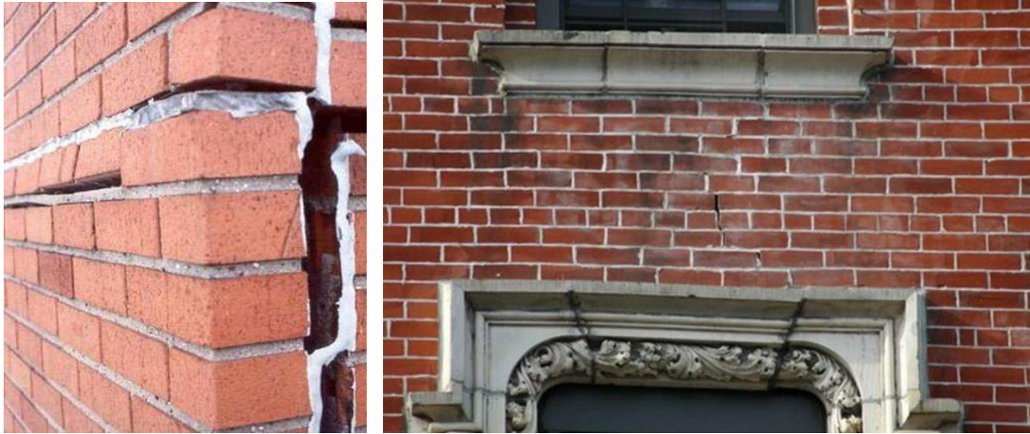
Şekil 24: Cephede oluşan eğilme ve bükülme şeklinde deformasyonlar (URL-5)
