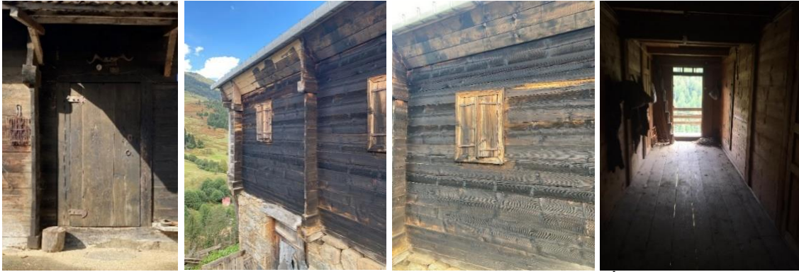
Şekil 6: Konut Kapıları (G7), Kurtboğaz Sistemi (K11), Pencere/Kepen ilişkisi (K11) ve B Plan Tipine Ait Geçiş Alanı Görünümü (G11) (Topcu, 2021)
