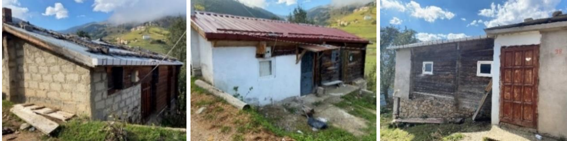
Şekil 10: Aşhane Taş Duvarlarındaki Değişim (K8), Çatı Örtüsünün Saç Malzeme ile Değiştirilmesi (K9), Büyüklüğü Değişen Kapı-Pencereler (G11) (Topcu, 2021)
