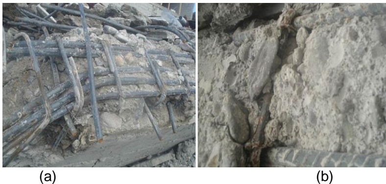
Şekil 45 (a, b). (a) Nervürsüz İnşaat Demiri ile Nervürsüz ve (b) Nervürlü Demirin Birlikte Kullanıldığı Yapı Elemanları (URL-9)
