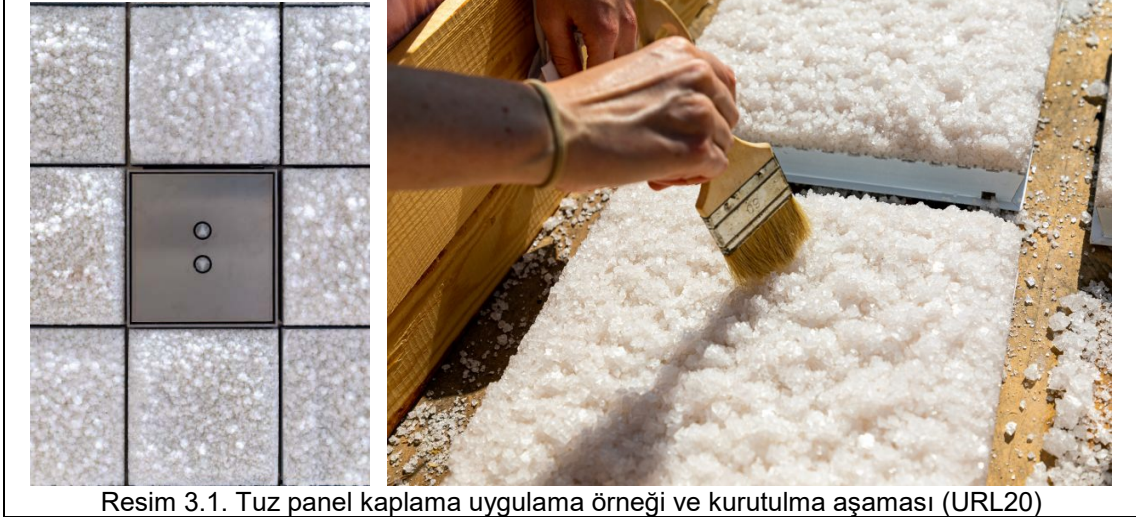
Resim 3.1. Tuz panel kaplama uygulama örneği ve kurutulma aşaması (URL20)
