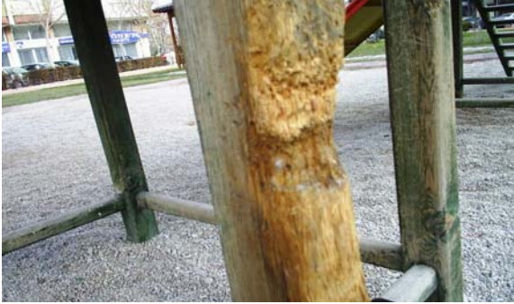
Şekil 15. Nenehatun parkında salıncağın çarpması sonucu zedelenmiş taşıyıcı ahşap detayı (Orijinal 2007).
