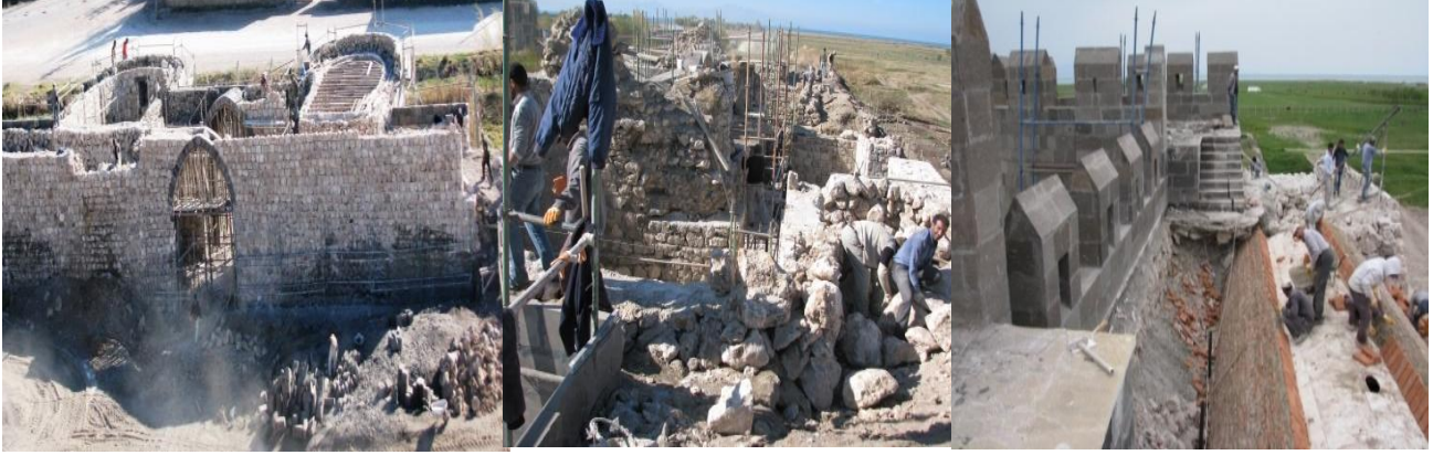
(a) (b) (c) Şekil 35. Saray Kapısı (a) Onarım çalışması görünüşleri; (b) Onarım çalışması görünüşleri; (c) Onarım çalışması görünüşleri ( Kaynak: (a,b,c) Yazarın kişisel arşivi, 2012).
