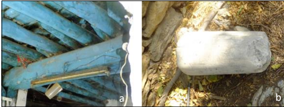
Şekil 8. Toprak dam sisteminin karakteristik elemanları (a) Düver elemanı ve mertekler; (b) Dambaş yuvarlağı ( Kaynak: (a),(b) Gülendal Cilli kişisel arşivi).
