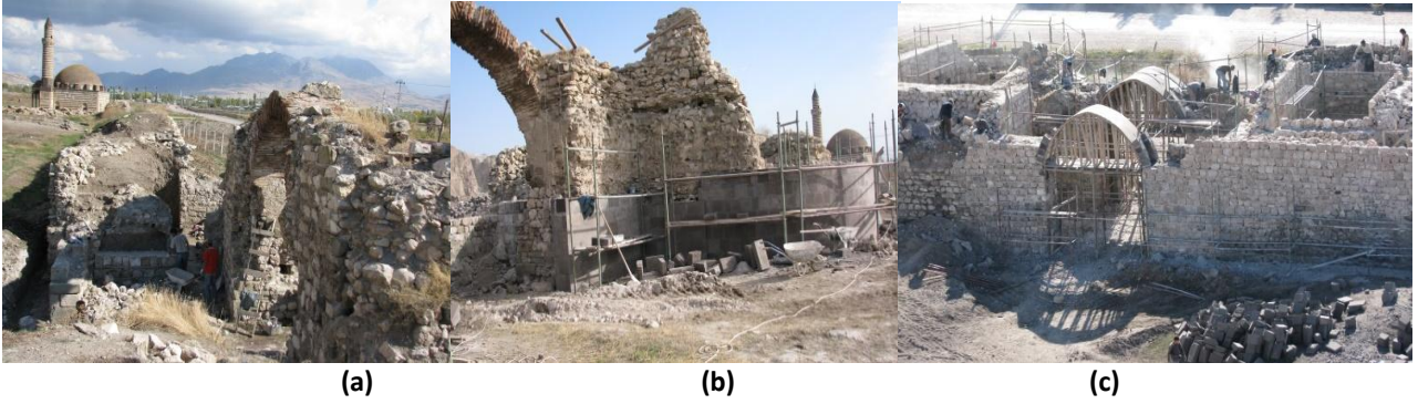
Şekil 30. Saray Kapısı (a) Onarım çalışması görünüşleri; (b) Onarım çalışması görünüşleri; (c) Onarım çalışması görünüşleri ( Kaynak: (a,b,c) Yazarın kişisel arşivi, 2012).
