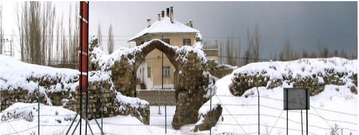
Şekil 19. Eski Van Şehri Saray Kapısı kuzey görünüşü ( Kaynak: Yazarın kişisel arşivi, 2006).
