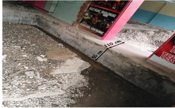
Şekil 9: İlkokulunun tespit edilen temel boyutları.
