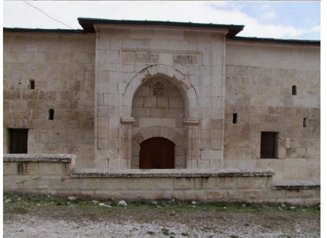
Şekil 2. Yapının Kuzey-Batı cephesi
