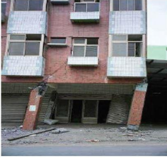
Şekil 4. Tasarıma bağlı yapı hasarı (yumuşak kat) (URL-1).
