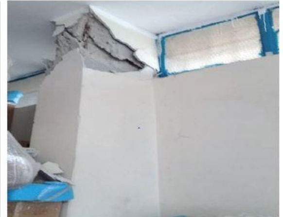
Şekil 6. Tasarımdan ya da sonradan kullanıma bağlı yapılan değişiklikten kaynaklı yapı hasarı (kısa kolon etkisi) (URL-1).
