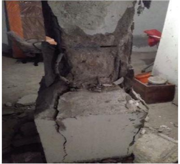
Şekil 5. Tasarım ve kötü işçilikten kaynaklı yapı hasarı (yetersiz sargı donatısı) (URL-1).
