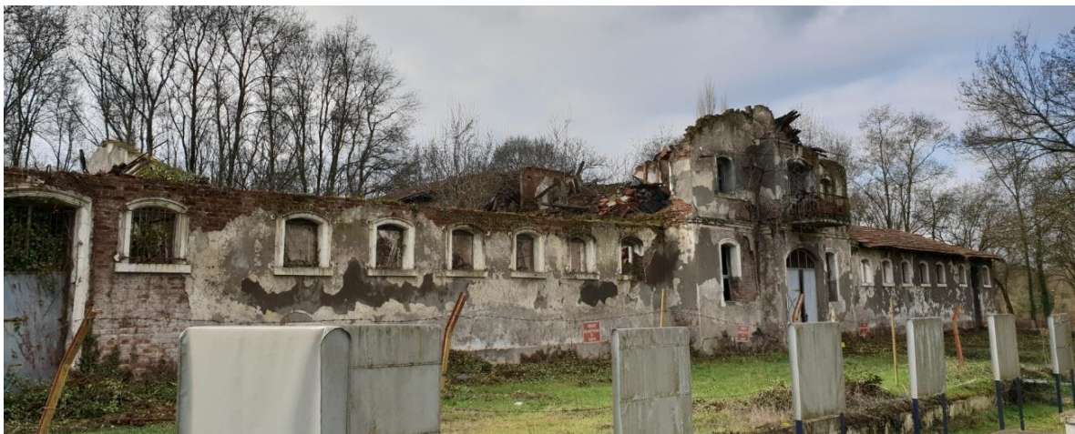
Figür 6. Yapının kuzey cephesi
