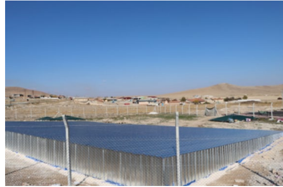
Fig. 11b. Koruyucu Çatının Etrafının Tel Örgü ile Çevrilmesi
