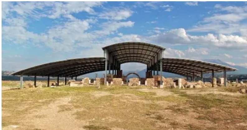
Fig. 15. Laodikeia Kilisesi Koruyucu Çatı Örtüsü (Tarkan 2018, 173)
