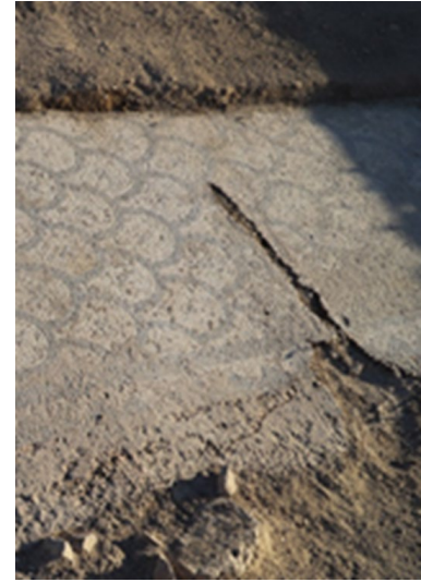
Fig. 1. Sol Nef Mozaiginde Çatlak Görünümü
