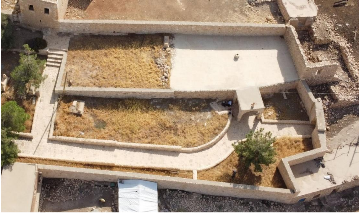
Fotoğraf 17: Mor Bobi Kilisesi, Hava Fotoğrafı, Genel Görünüm
