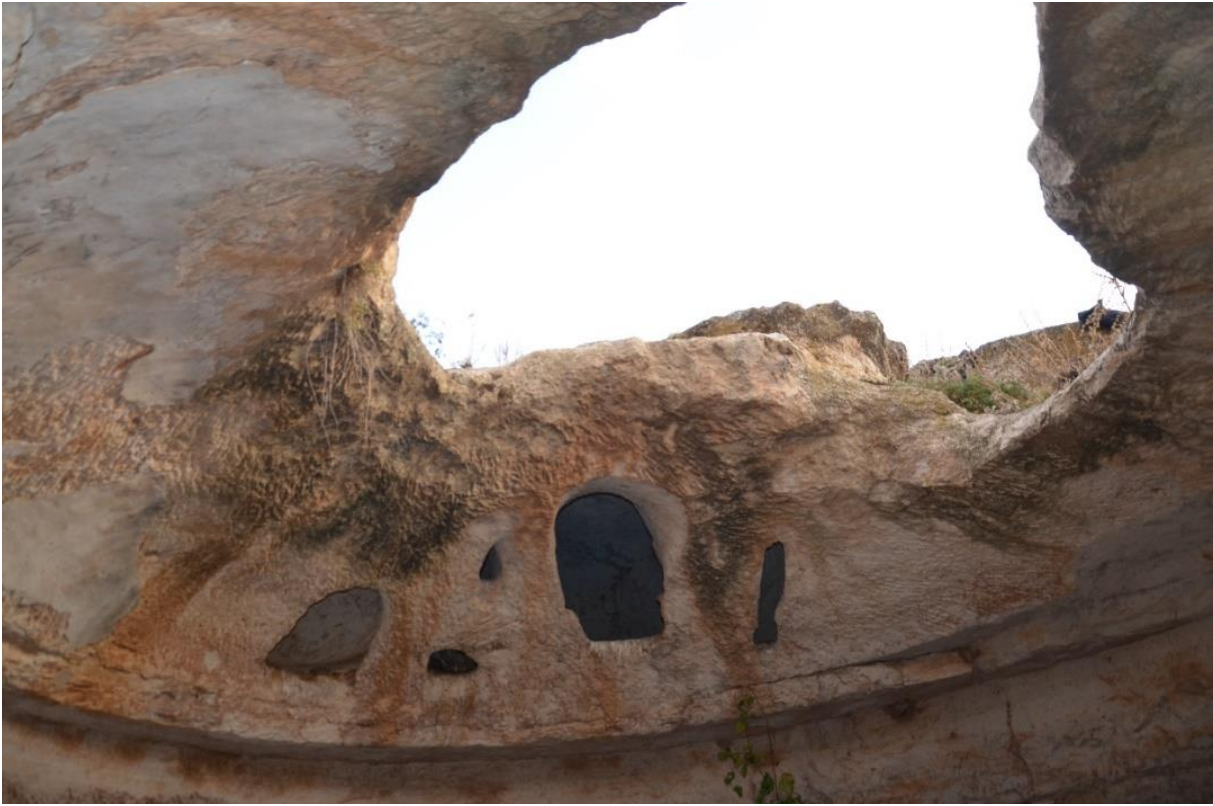
Fotoğraf 10: Mor Barsavmo Kilisesi, Galeri Katı-2018
