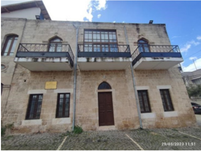
Figür 18: Ana yapının Restorasyon Sonrası Ön Cephesi (Ahmet Şanverdi, Kişisel Arşiv 29.03.2023)
