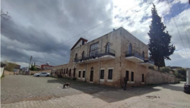
Figür 12: Kuzey ve Batı Cephesi (Ahmet Şanverdi, Kişisel Arşiv 29.03.2023)
