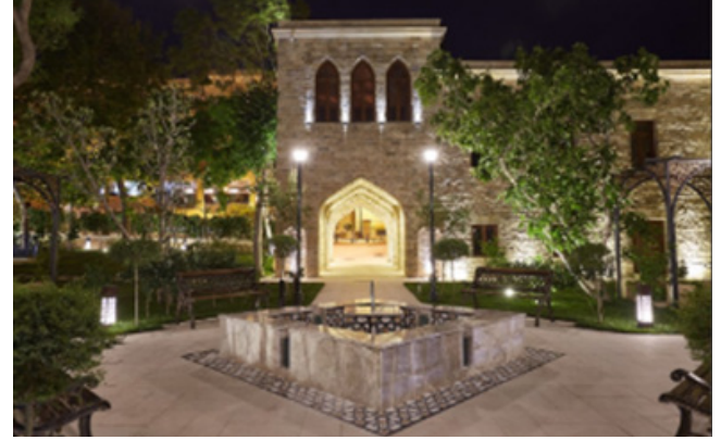
Figür 4: Bakü Han Sarayı Külliyesinin onarım sonrası durumu
