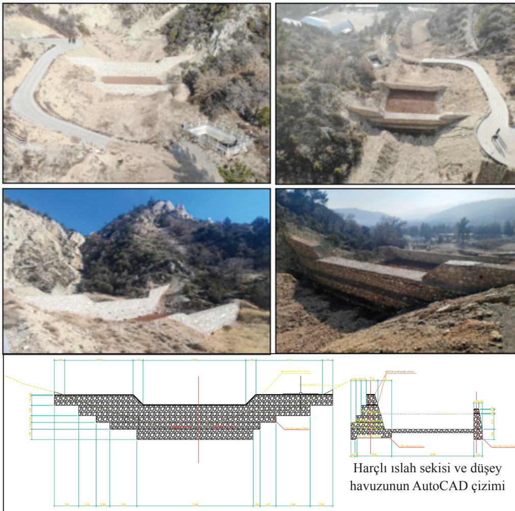
Şekil 8. Uygulaması yapılan sel kontrol yapısı Harçlı Islah Sekisinin görüntüsü (Koordinat X:359343.09, Y:4451224.70- WGS1984 UTM ZONE 36N Koordinat Sisteminde) ve harçlı ıslah sekisi en kesiti (AutoCAD – tüm çizimler metre olarak verilmiştir).
