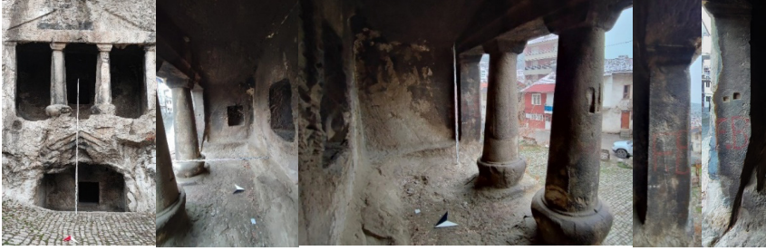
Şekil 3: İskilip A Kaya Mezarı Cephe, Portiko ve Sütunlar (O. GÜNDOĞDU, 2022)
