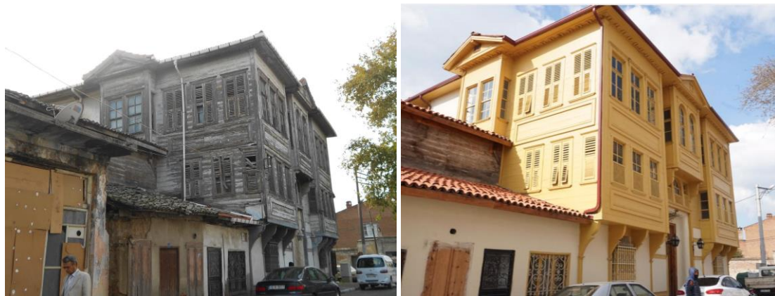
Şekil 4. Terzizade Sadettin Bey Konağı (solda) (Hayriye İsmailoğlu, 2014), Terzizade Sadettin Bey Konağı (sağda) (Anonim, 2019)
