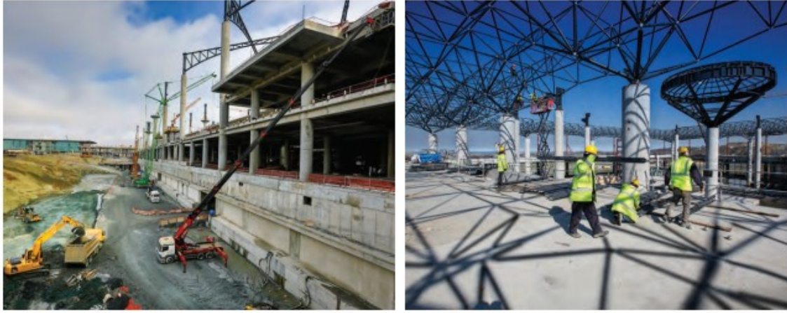
Şekil 9. Havalimanı terminali inşa süreci (Şengül ve ark., 2022).
