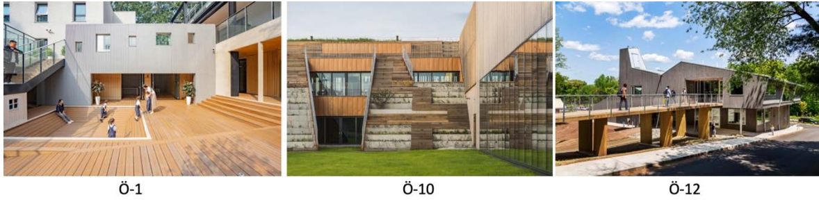
Şekil 7. Ahşabın Dış Mekanda Zemin ve Basamak Kaplama Malzemesi Olarak Kullanımı.
