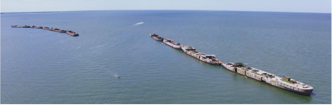
Şekil 5. Kiptopeke sahilinde dalgakıran amaçlı konumlandırılan beton gemiler görülmektedir.
