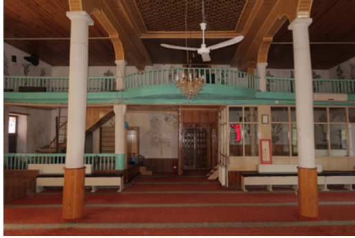
Şekil 10: Afyonkarahisar Başmakçı Recep Bey Camii, kuzey duvarı
