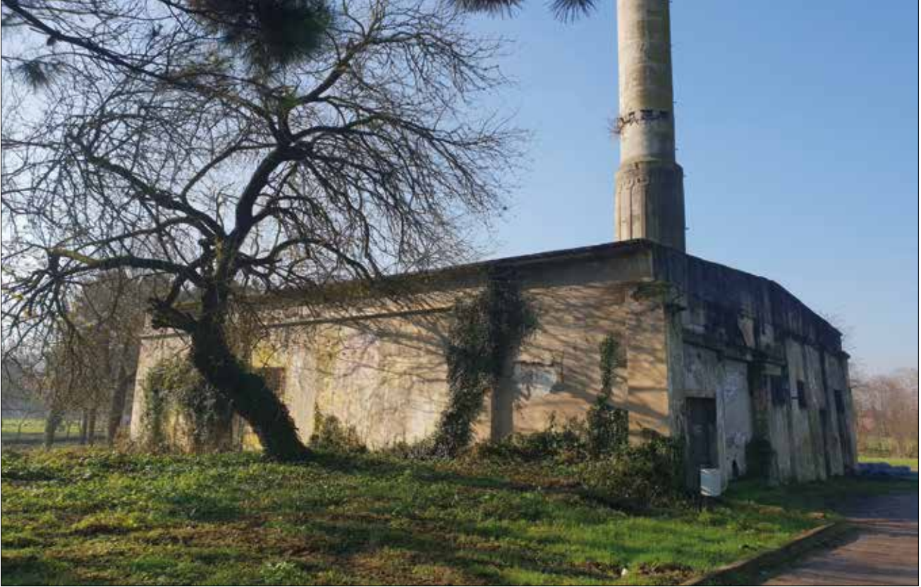
Fotoğraf 3. Bacalı ambarın kuzeybatıdan görünüşü / The view of the warehouse from the northwest (Kahraman and Boduroğlu, 2019)
