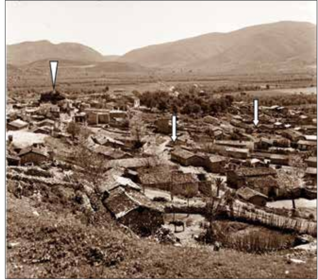
Fotoğraf 14. Ayasuluk-Selçuk Atatürk Mahallesi (1955) 1. Zaviyeli Cami yıkıntıları, 2. Zaviyeli Cami'nin yeri, sol üstte İmaret (Şimdi Ayasuluk Kütüphanesi). / Ayasuluk-Selçuk Atatürk Neighborhood (1955) The ruins of the 1st Zaviya Mosque, the location of the 2nd Zaviya Mosque, Imaret on the upper left (now the Ayasuluk Library).
