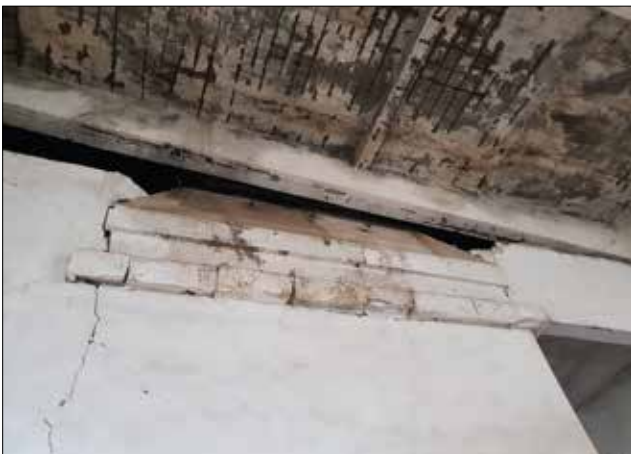
Fotoğraf 8. Ambar-1 içerisindeki baca kaidesinin kornişleri / The cornices of the chimney base in the Warehouse-1.
