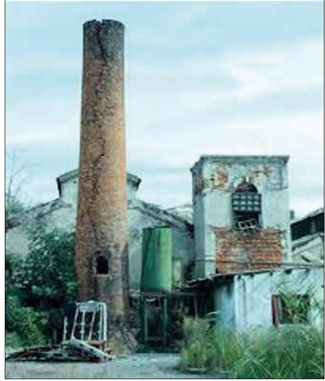
Fotoğraf 11. Osmanlı Kibritleri Fabrikası kuzeybatı cephesi (Kıraç, 2018). / The northwest facade of the Ottoman Match Factory (Kıraç, 2018).
