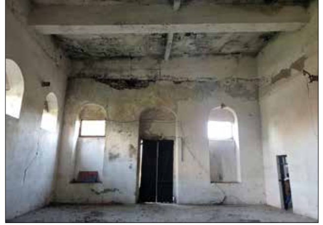
Fotoğraf 6. Z02 no.lu mekan (Ambar-2) / Room Z02 (Warehouse-2).
