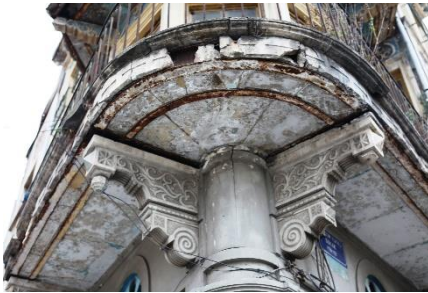
Foto. 12-14. 1. kat çıkma ayrıntısı; çelik kiriş, taş konsol, kat silmesi ayrıntıları
