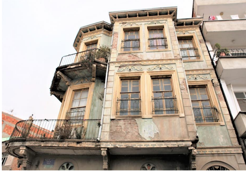
Foto. 7. Ön cephe 1. ve katlar
