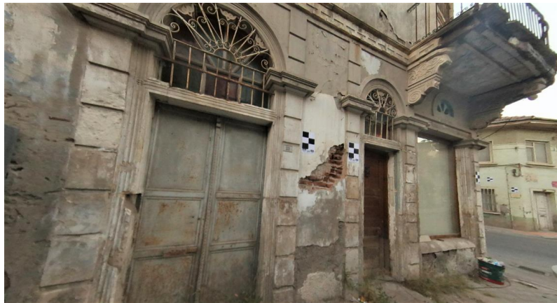
Foto. 8. Sol yan cephe zemin kat
