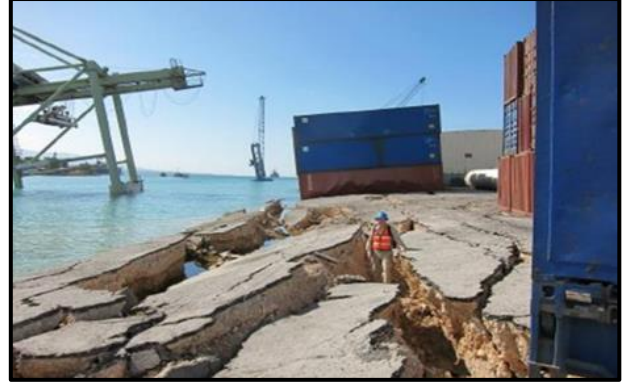
Şekil 12. Haiti'de 2010 yılında yaşanan deprem sonucu oluşan yanal yayılma (Altındış, 2020)
