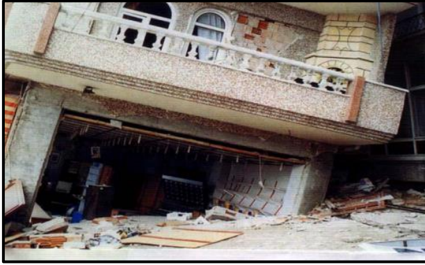
Şekil 7. 1999 Adapazarı depreminde sıvılaşma sonucu zemine gömülmüş bina (Ulusay, 2000)
