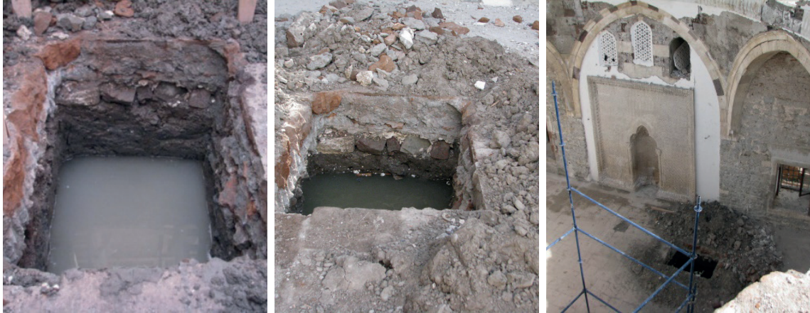
Fotoğraf 90-92: Kaya Çelebi Camii Sondaj Kuyusu ve Drenaj Onarım Görünüşleri (Kaynak: Ş. Öztürk, 2012)
