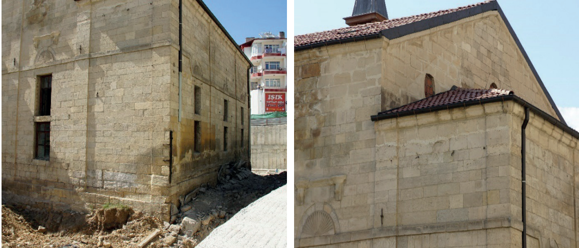
Şekil 16: (a) Restorasyon Sırasında Yapılan Araştırma Kazısı ve (b) Çatı Sökülüp İçeride Sıva Raspaşı Yapılınca Ortaya Çıkan Yuvarlak Tepe Pencereleri (2018)
