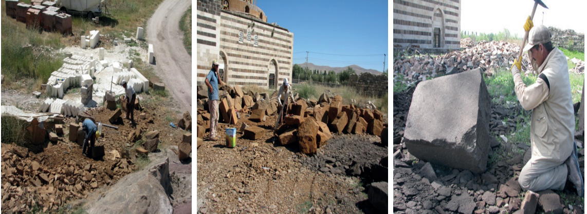
Fotoğraf 20-22. Kaya Çelebi Camii Onarım Malzeme Görünümleri (Kaynak: Ş. Öztürk, 2013)
