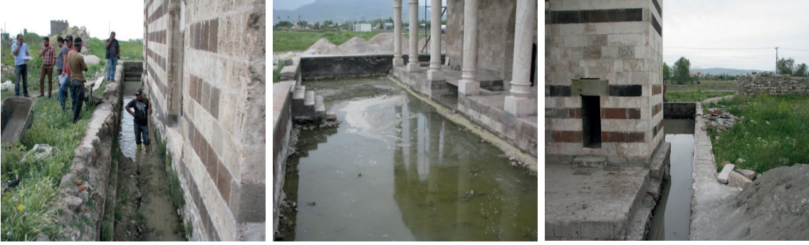
Fotoğraf 93-95: Kaya Çelebi Camii Sondaj Kuyusu ve Drenaj Onarım Görünüşleri (Kaynak: Ş. Öztürk, 2012)
