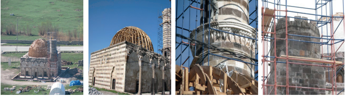
Fotoğraf 69-72: Kaya Çelebi Camii Kubbe ve Minare Onarım Görünüşleri (Kaynak: Ş. Öztürk, 2011)
