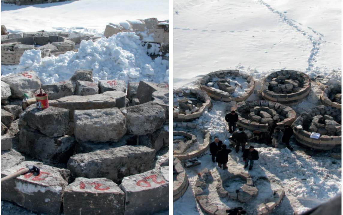
Fotoğraf 55-59: Kaya Çelebi Camii Minare Söküm Çalışması Görünüşleri (Kaynak: Ş. Öztürk, 2011)
