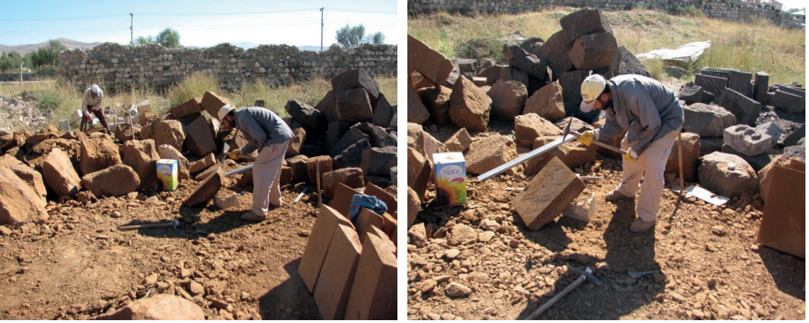
Fotoğraf 23, 24. Kaya Çelebi Camii Onarım Malzeme Görünümleri (Kaynak: Ş. Öztürk, 2013)
