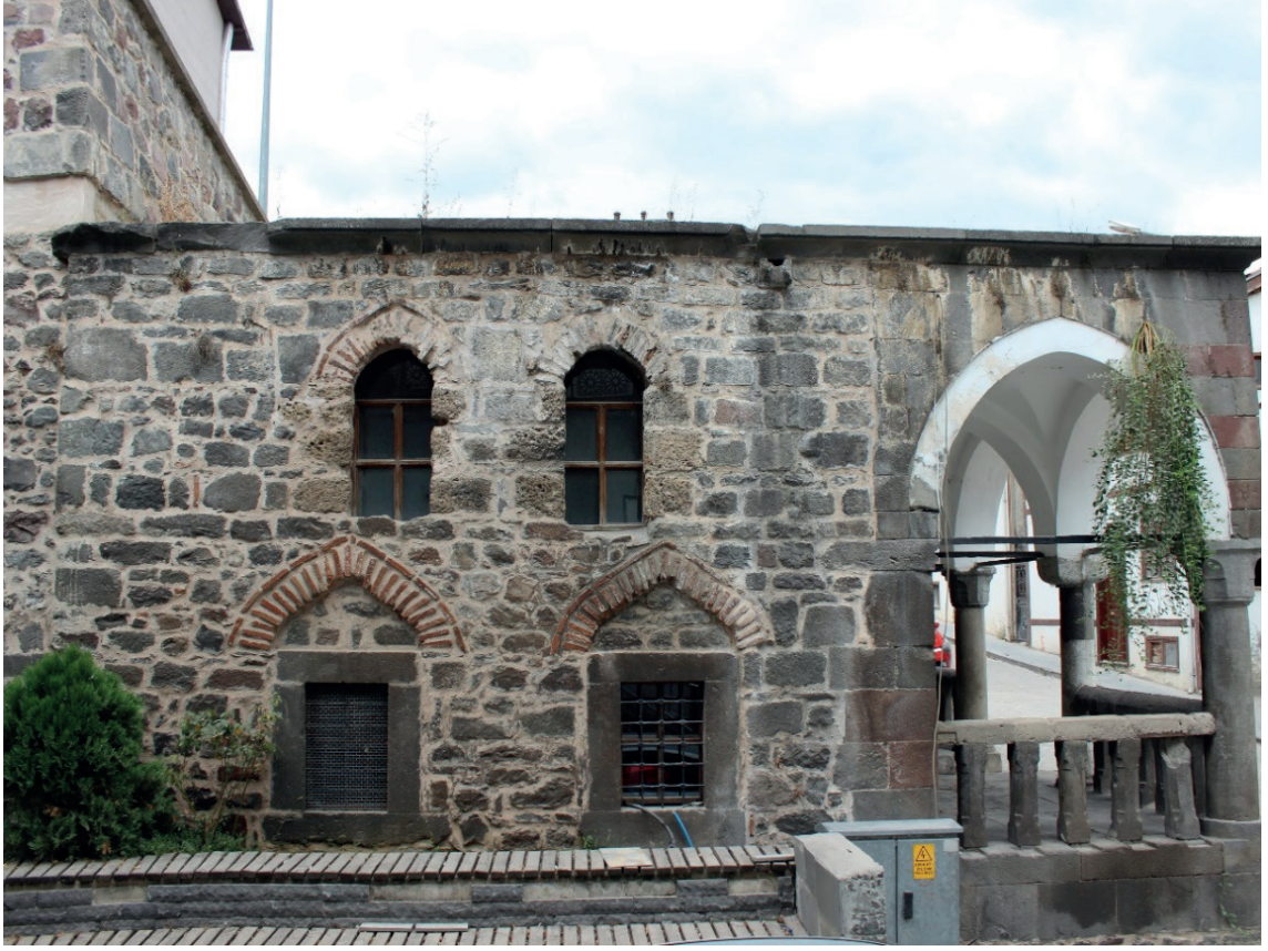
Resim 16: Taş Mektep, batı cephe görünümü
