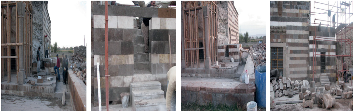
Fotoğraf 65-68: Kaya Çelebi Camii Minare Onarım Görünüşleri (Kaynak: Ş. Öztürk, 2011)
