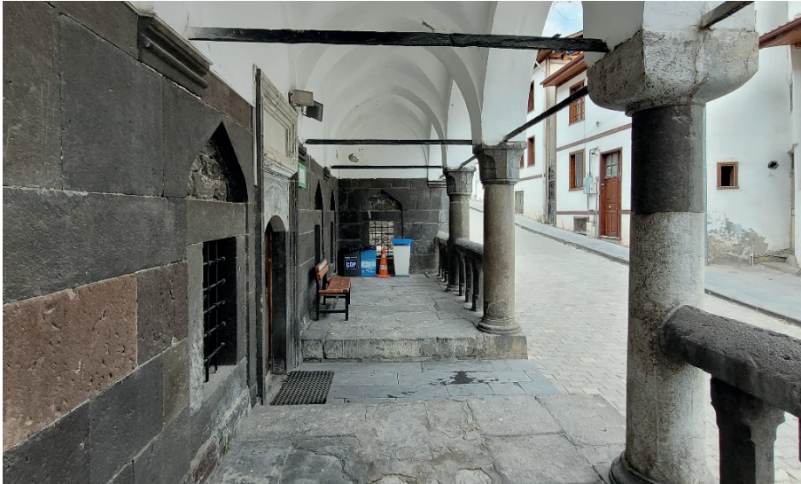
Resim 8: Güney cephedeki revaktan görünüm
