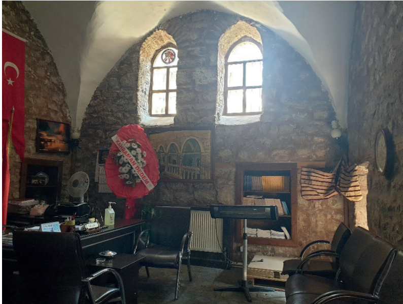
Resim 14: Taş Mektep, doğu oda, doğu duvar
