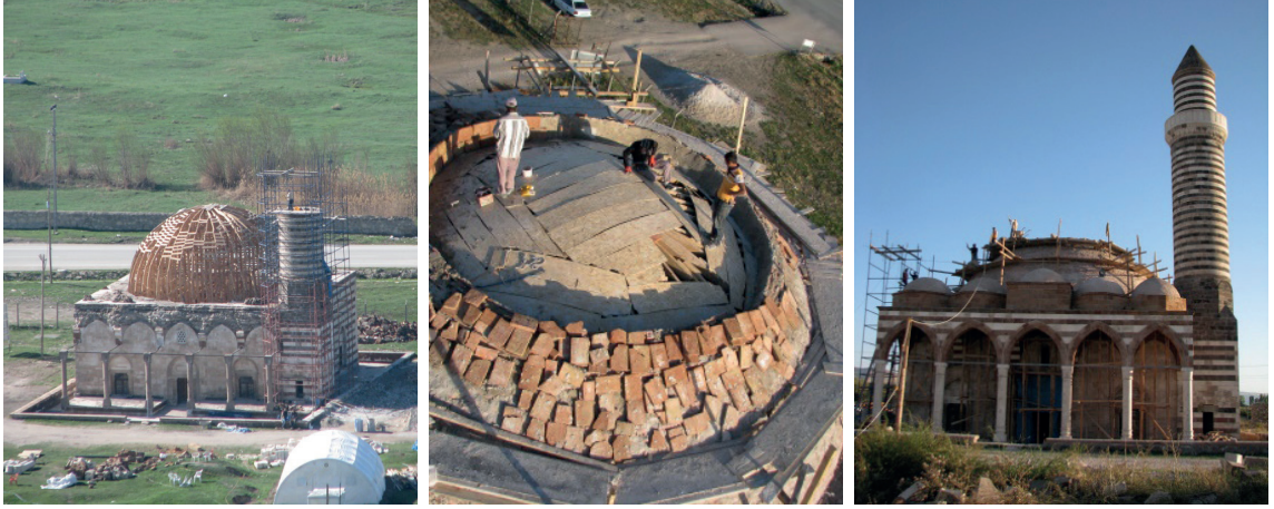
Fotoğraf 82-84: Kaya Çelebi Camii Onarım Görünüşleri (Kaynak: Ş. Öztürk, 2013)
