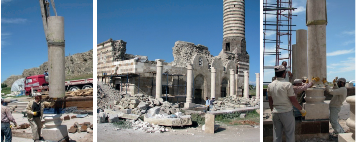
Fotoğraf 85-87: Kaya Çelebi Camii Onarım Görünüşleri (Kaynak: Ş. Öztürk, 2013)
