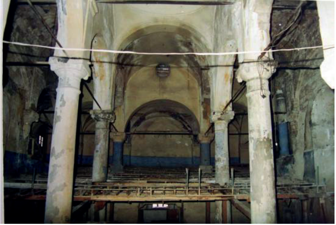
Şekil 7: Naostan galeriye bakış, kaldırılan kubbenin pandantifleri (Yozgat Müftülüğü, 1990).
