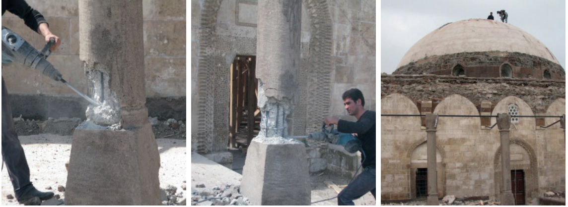
Fotoğraf 62-64: Kaya Çelebi Camii Deprem Sonrası Söküm Çalışma Görünüşleri (Kaynak: Ş. Öztürk, 2011)
