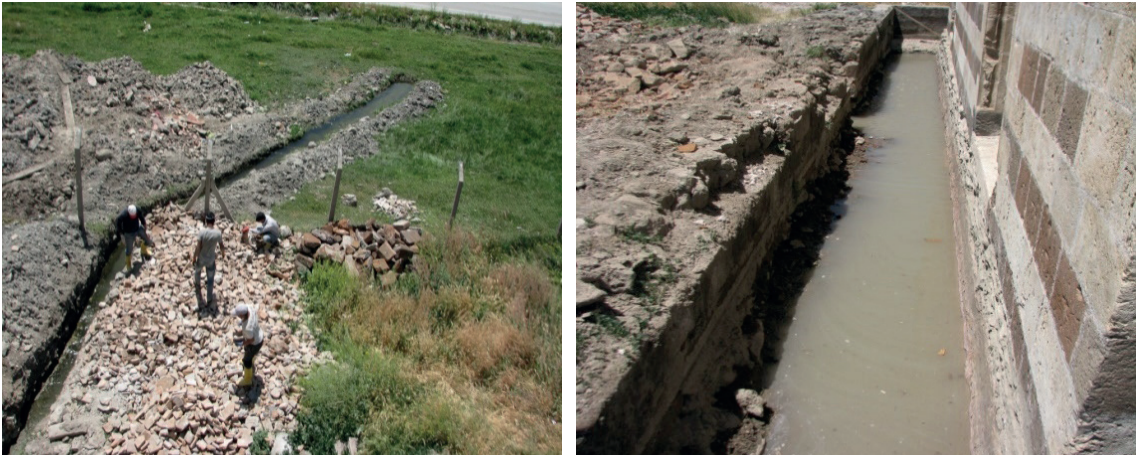
Fotoğraf 97, 98: Kaya Çelebi Camii Drenaj Güzergâh Görünüşleri (Kaynak: Ş. Öztürk, 2012)
