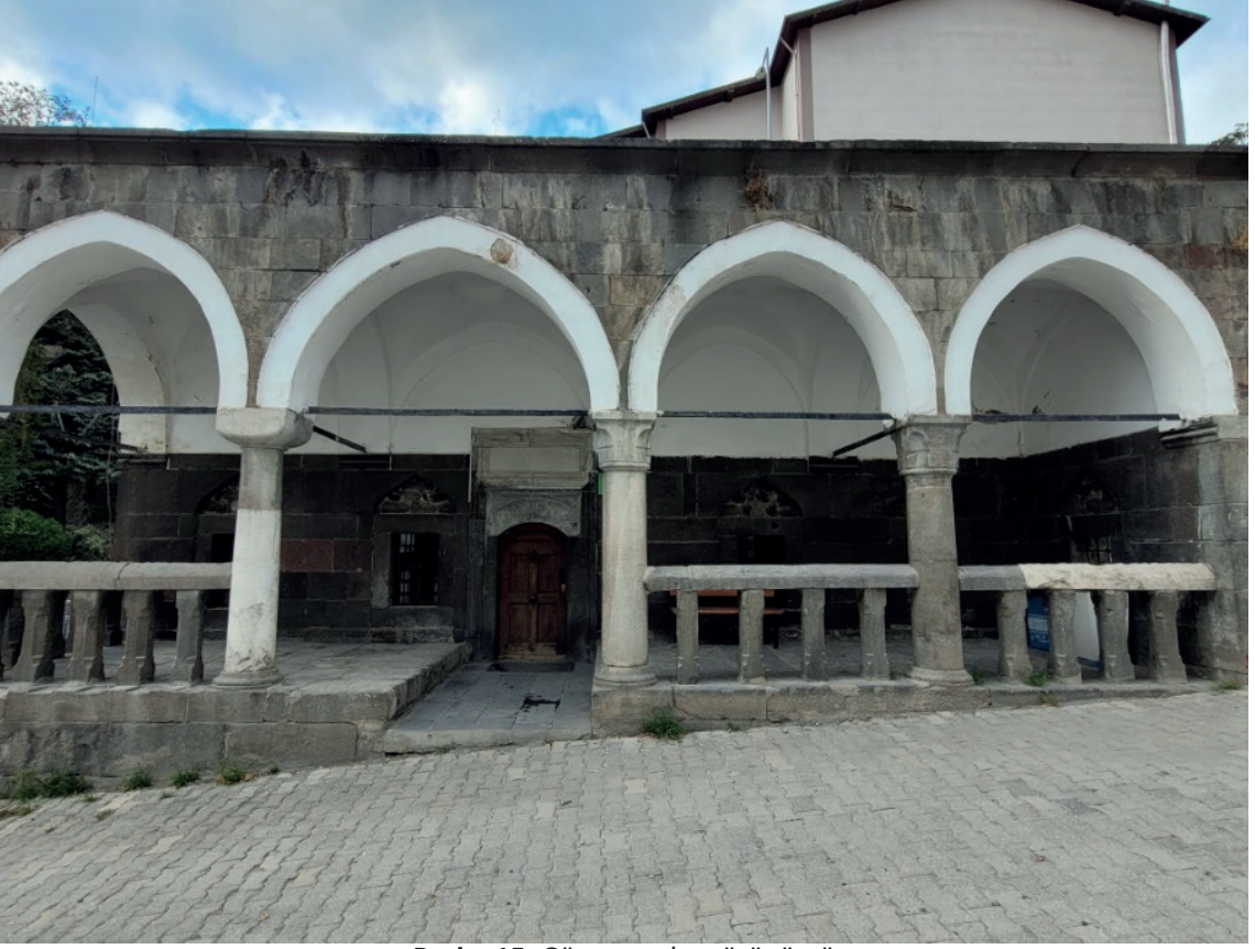
Resim 15: Güney cephe görünümü
