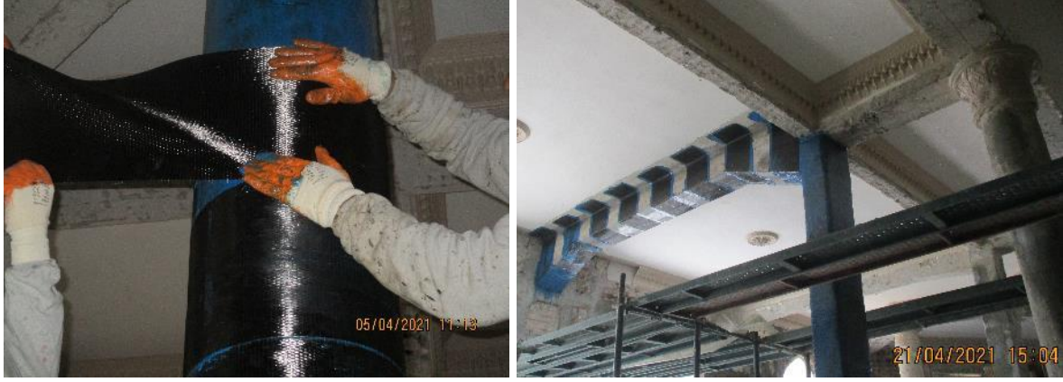
Şekil 8 - CFRP kumaşla betonarme elemanlarla güçlendirme uygulaması (Nisan 2021).
