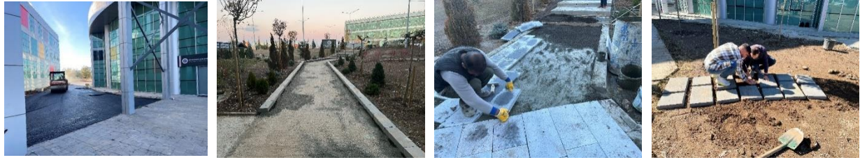
Şekil 5. Alandan geçirilen yolların ve döşeme malzemelerinin yapılması çalışmaları.
