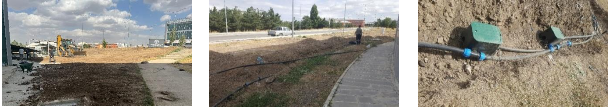
Şekil 4. Tesviye çalışmaları ve otomatik sulama tesisatı çalışmaları.
