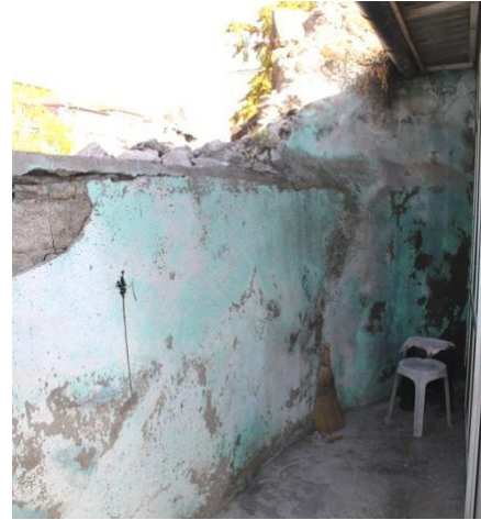
Fotoğraf 14. Özgün kuzey cephe duvarları
