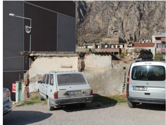
Fotoğraf 2. Türbenin güney cephesi
