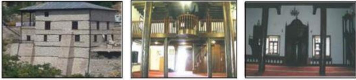
Kurtuluş (Mormi) Cami Dış ve İç Mekânı
