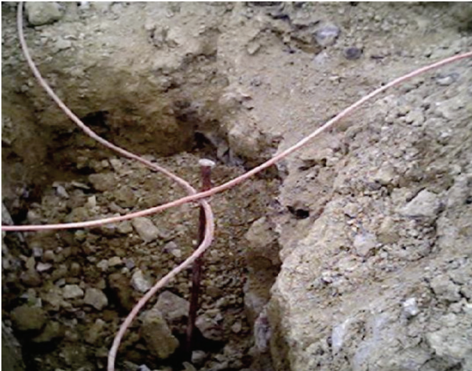
Şekil 1. Yüksek gerilim şalt sahası topraklama ağı
