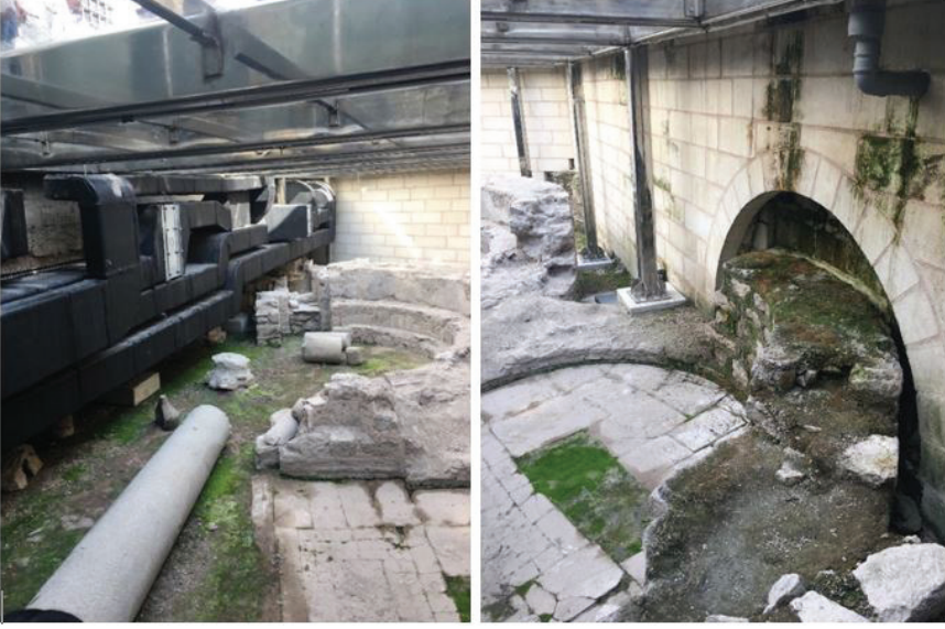
G. 21: Beyazıt İmaretî'ndeki kalıntı alanında havalandırma sistemi ve cam örtüsünde su gideri (Neşe Karaçay, 2018)
