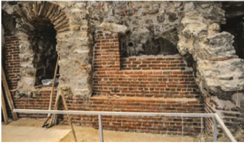
G. 7: Yeni tuğla ile örülen destek duvarları (Soysal, “İbrahim Paşa Sarayı İkinci Avlu Zemin Kotunda Yer Alan Kalıntıların Koruma ve Onarım Çalışmaları”, 113); toprak görünümlü destek duvarları (Neşe Karaçay, 2022).
