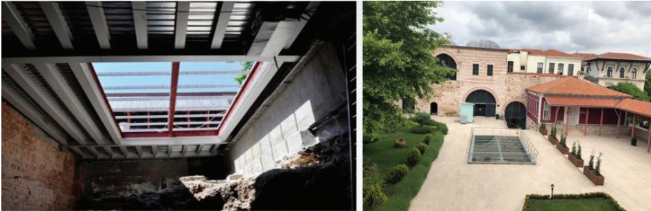
G. 9: Çelik taşıyıcılı cam döşeme uygulaması, Mayıs 2014 (İstanbul IV Numaralı Kültür Varlıklarını Koruma Bölge Kurulu Arşivi); İbrahim Paşa Sarayı'nın 2. avlusundaki görüntüsü (Neşe Karaçay, 2018).
