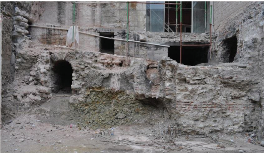
G. 5: Kazı alanının kuzey-doğu yönündeki almasıık duvar (İstanbul IV Numaralı Kültür Varlıklarını Koruma Bölge Kurulu Arşivi- Ekim 2012)
