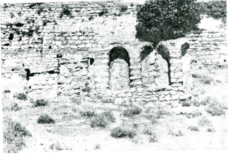
Res. 29 — Pammakaristos'un doğu istinat duvarı önünde küçük bir sarnıç Fig. 29 — A small cistern near the Eastern retaining wall of the Church of Pammacaristos.
