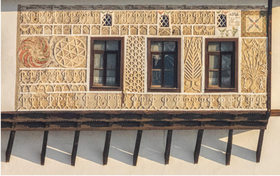
Görsel 15. Müderrisler evinin dış cephe görünümü.
