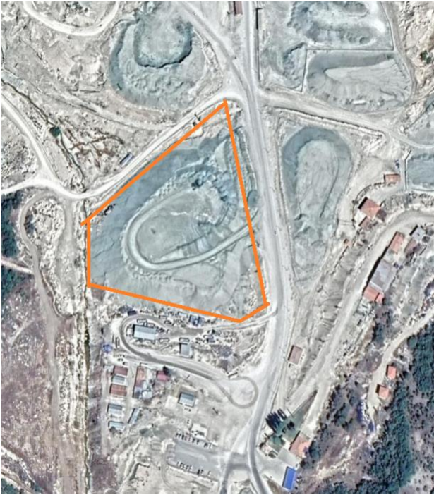
Şekil 2. Tesis içerisindeki stok alanı (int. Kyn. 2).
