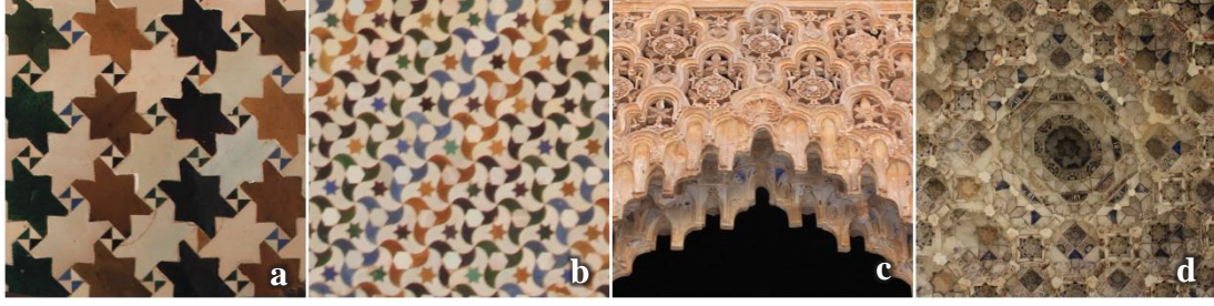
Şekil 6: Elhamra Sarayı'ndan Modüler Yüze Tasarımı ve Simetrik Düzen : (a) "4*2" Türü Alt Katman Üzerine Zilliç Tekniği İle Üretim ve "o" Grubu Renk Katmanı. (b) "333" Türü Alt Katman Üzerine Zilliç Tekniği İle Üretim ve "o" Grubu Renk Katmanı, Palacio De Comares, Patio De Los Arrayanes. (c) Yapı Kemerlerinde Alçı İşçiliği İle "*x" Türü Simetrik Örüntünün Mekânsallaşması. (d) Tam ve Yarım Sekiz Köşeli Yıldız Biçimli Merkezler Aracılığıyla Üretilmiş Tavan Mukarnası (Fotoğraflar: Korcan Gülfidan, 2015, Granada, İspanya).
