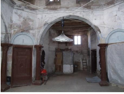
Şekil 19 Kubbe Taşıyıcılığında kemerler (Tavacıgil, 2007c)
