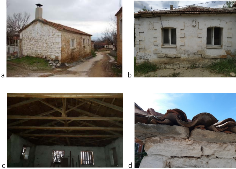
Şekil 23. a. KTLG-8 Beşik çatı b. ENV-22 Kırma çatı c. ENV-15 Çatı strüktürü d. KTLG-18 Saçak.
