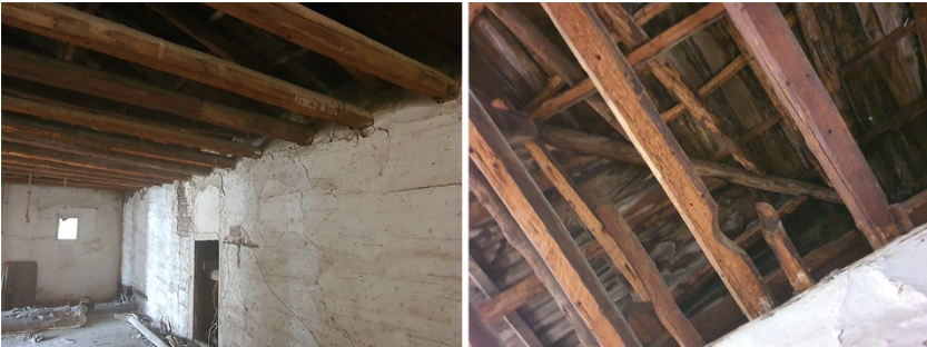
Şekil 12. Çatı taşıyıcı sistemi genel görünümü.
