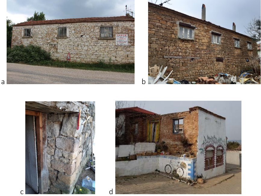
Şekil 16. a. KTLG-23, Yiğma yapım tekniği ile yapılmış konut b. KTLG-17, Yöresel taşın cephelerde kullanımı c. ENV-3, Duvar örgüsü d. KTLG-13 taş ve tuğla kullanımı.
