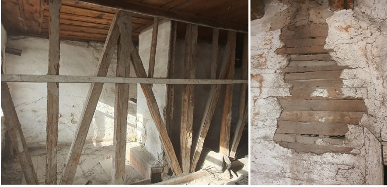
Şekil 10. Handaki bağdadi duvar örgüsü.
