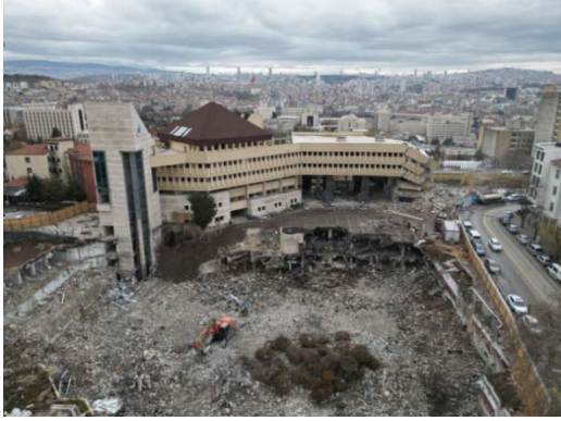
Şekil 14. Belediye Binası Yıkımı (URL-7).
