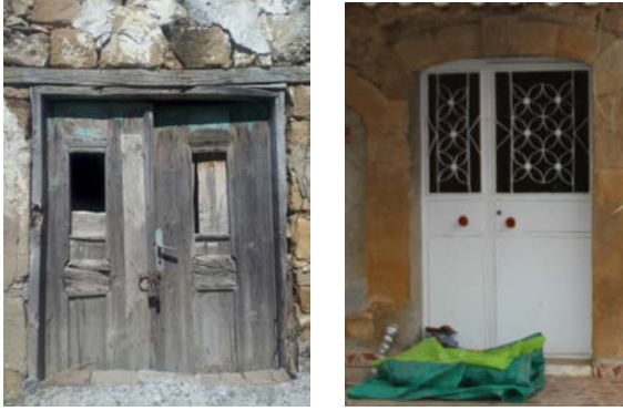
Şekil 18. KTLG-11 Özgün ahşap kapı ve ENV-22 Muhdes demir kapı.
