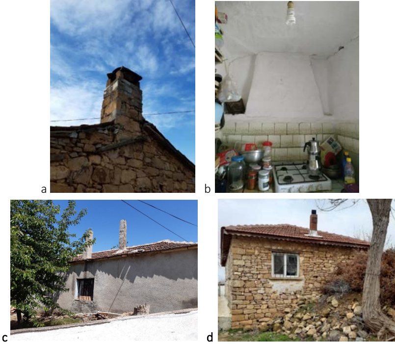
Şekil 24. a. KTLG-20 Özgün baca b. KTLG-17 Ocak bacası c-d. ENV-8 ve KTLG-1 Müdahale gören baca örnekleri.
