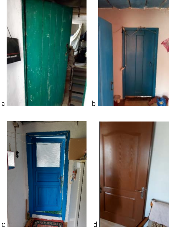
Şekil 20. a. KTLG-9 Çakma kapı b. KTLG-4 Tablalı kapı c-d. Muhdes kapı.
