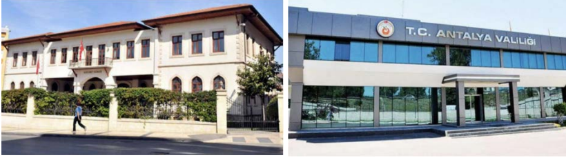
Şekil 6-7. Antalya Valilik Binası, Antalya Valilik Ek Binası (URL-2, URL-3).
