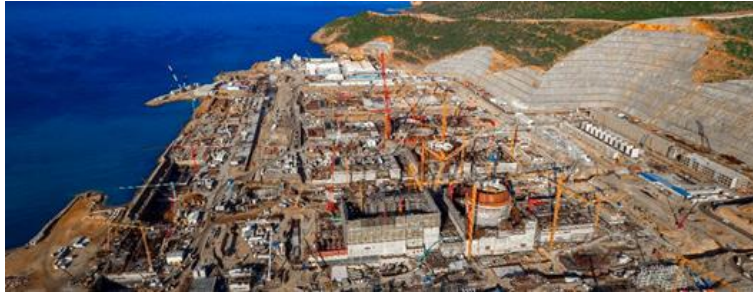
Şekil 2. Akkuyu Nükleer Santral İnşaatı (Akkuyu Nükleer A.Ş.)
