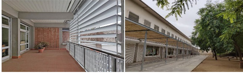
Şekil 8. Poblenu ve Villa Olimpica Okullarında Güneş Kontrolü Elemanları (Soldan Sağa Dođru) (Cartalis, 2021b).
