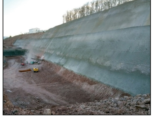
Fotoğraf 1 - İnceleme alanı a) uydu görüntüsü b) çivili iksa uygulama görüntüsü
