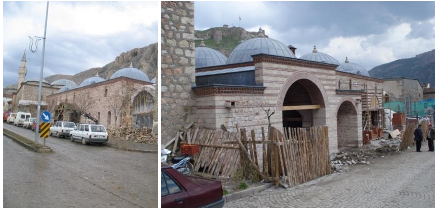
Foto. 10. Arastalı Bedesten Restorasyon Çalışmaları, 2007 (E. S. Akın Arşivi)
