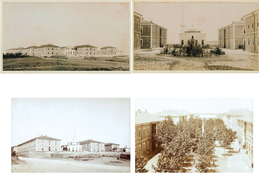
Şekil 5. Darülaceze dış cephe ve avlu görünümü, 1895.
