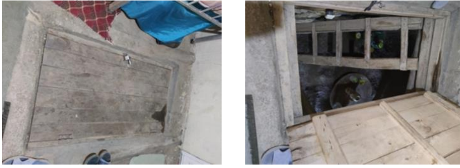
Resim 26. Öneri No: 21 Kilere Açılan Ahşap Kapak ve Merdiven
