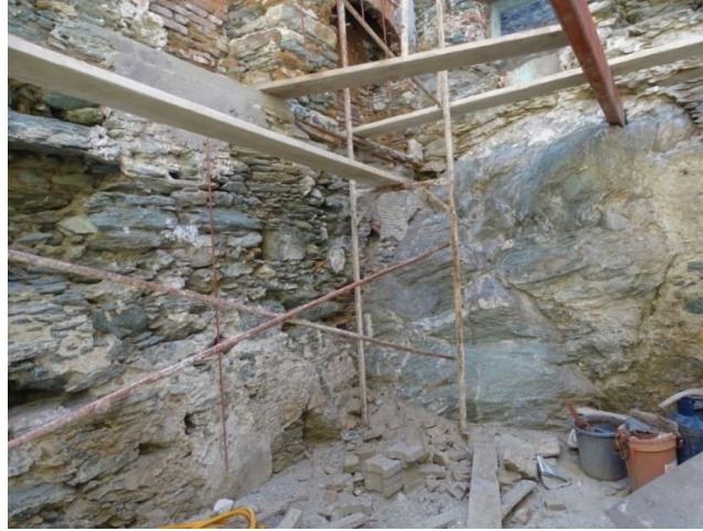
řekil 9. Zemindeki Yerel Tařın Duvarlarda Kullanımı (Kiřisel Arřiv)
