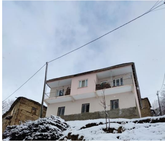
Resim 29. Betonarme Yeni Yapı
