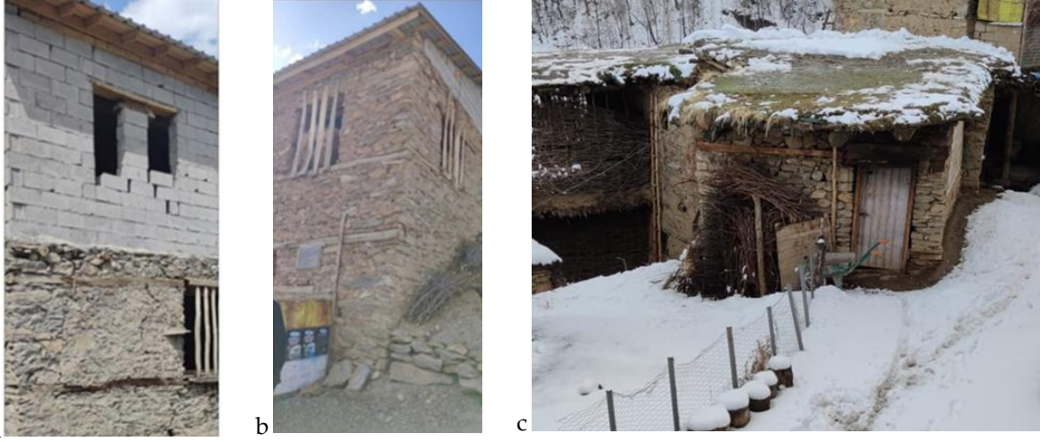
Resim 28. a-b. Özgün Üst Örtünün Eğimli Ahşap Konstrüksiyon Çatı ile Değiştirildiği Konut Örnekleri c. Dam Bakımı Yapılmayan Konutta Bitkisel Oluşumlar
