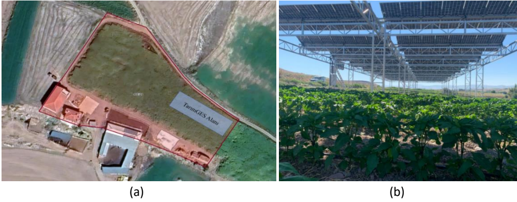
Şekil 1. Ankara'nın Ayaş ilçesi, Akkaya Mahallesinde kurulu TarımGES.
