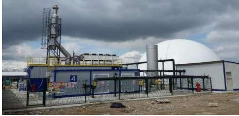
Görsel 13. Ereğli Enerji Üretim Tesisi
