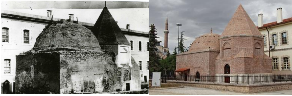
Görsel 9. Ulvi Sultan Türbesi ve Mescidi (Restorasyon Öncesi ve Sonrası)
