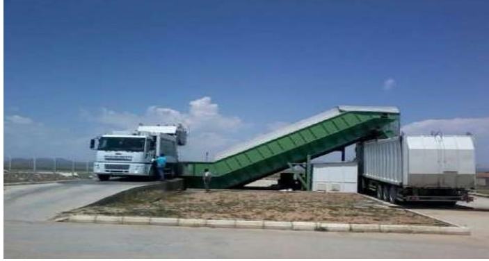
Görsel 11. Kulu Transfer İstasyonu
