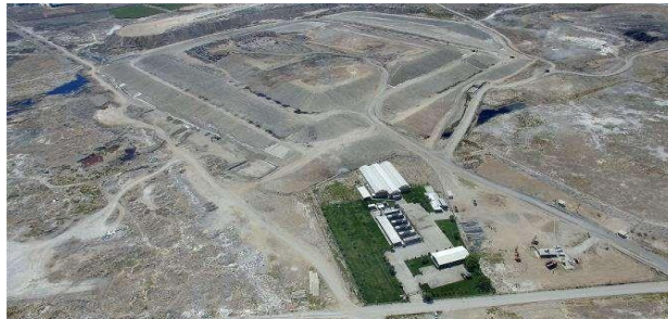
Görsel 3. Aslım Enerji Üretim Tesisi
