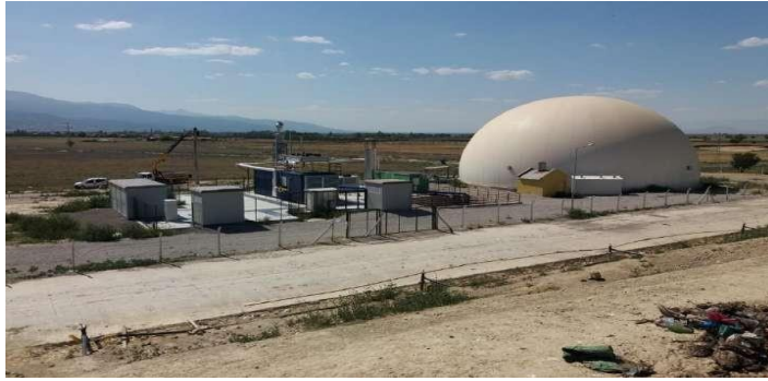
Görsel 10. Akşehir Enerji Üretim Tesisi
