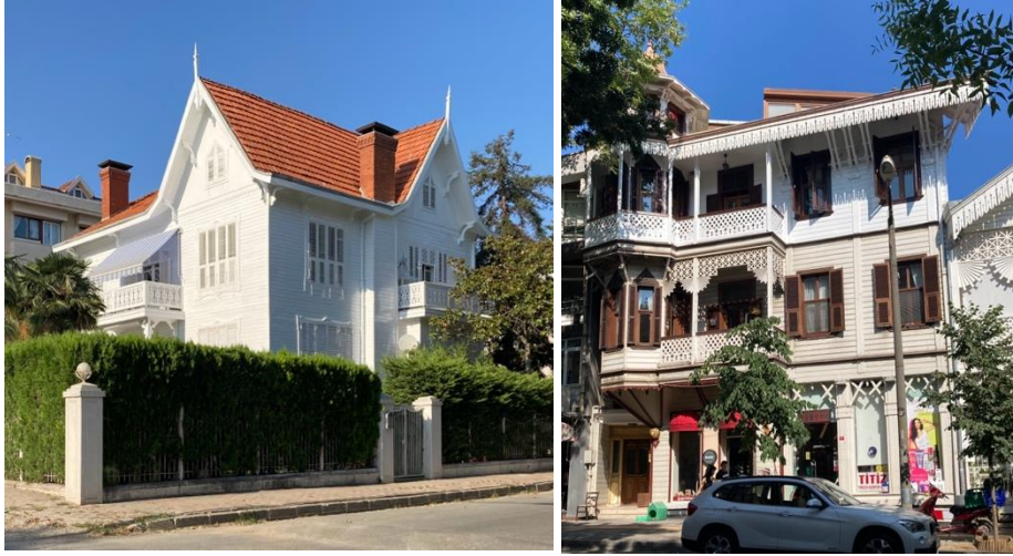
Şekil 10. Gelenbevîzâde Said Bey Köşkü (solda) Kuleli Ev (sağda) (Turangil, 2021)
