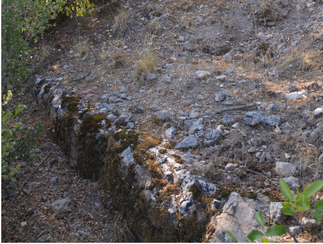
Fig. 25. Kuzey surlarının kesmetaştan örülmüş temel seviyesindeki kalıntılarının dış cephesi.
