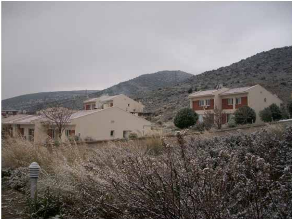
Şekil 3. İYTE Lojmanları, genel görünüm, tek katlı ve iki katlı konutlar. Foto: A.C. Benli, 2012.
