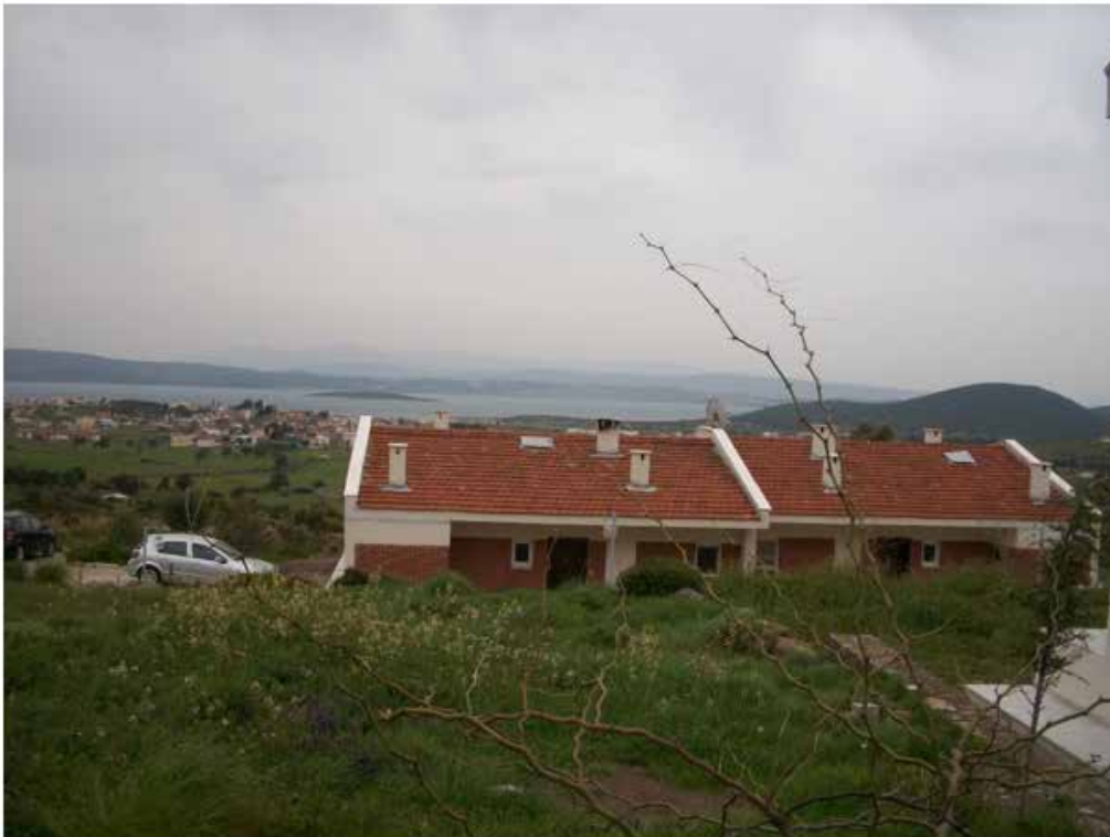
Şekil 9. İYTE Lojmanlarından Gülbahçe koyuna bakış. Foto: A.C. Benli, 2011.
